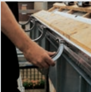
Montaż rynhaków obrotowych do szyny montażowej w obrębie krokwi
