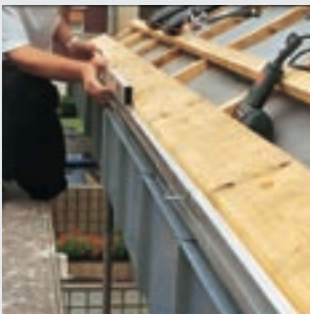
Kontrola podkonstrukcji nośnej pod względem jej ułożenia w płaszczyźnie i w pionie
