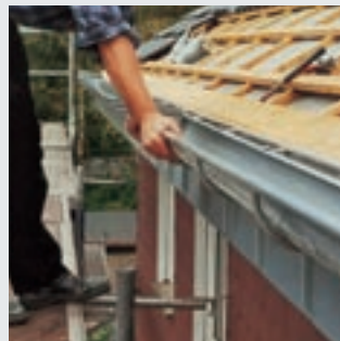
Docięnięcie rynny dachowej RHEINZINK® zapewnia umieszczenie jej w sposób pewny i trwały
